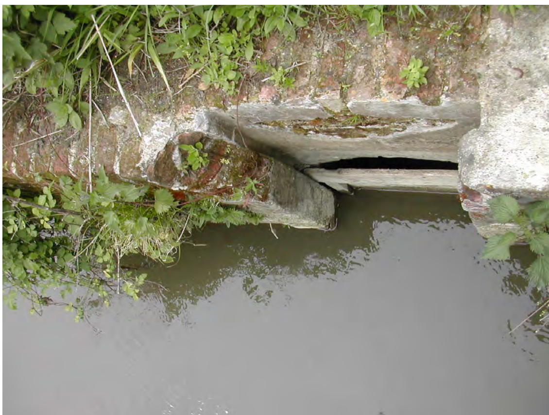
Figura 2.4 - Chiusino che regola l'ingresso delle acque di derivazione dalla Roggia Raina
